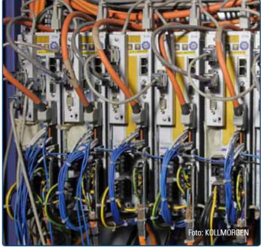
S700 Servo sürücülerini dolap içerisinde daha az alan kaplıyor.
